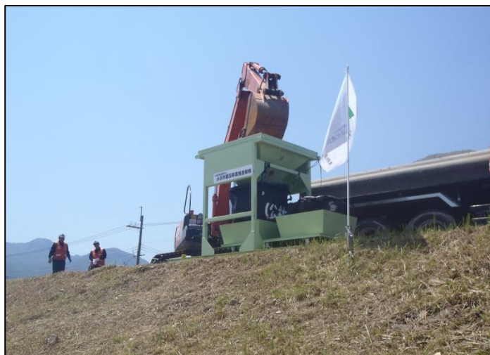
土のう作成機による 土のう作成
