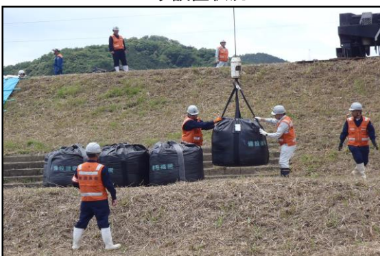
土のう設置状況
